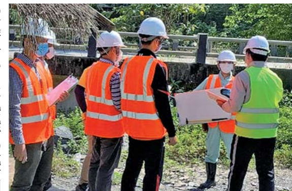
橋梁維持管理強化プロジェクトでの技術指導の様子
