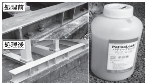
献することができる。さらに、深刻な問題として懸念されるコンクリート建造物に使用される鉄筋の錆について、その抑制・補修に有効な表面処理剤の開発を現在進めているほか、緑青や赤銅のように、内部の腐食を抑制しつつ表面に美術・工芸的な意匠性を有するパネルの開発もっており、多様な事業化展開が期待される。
