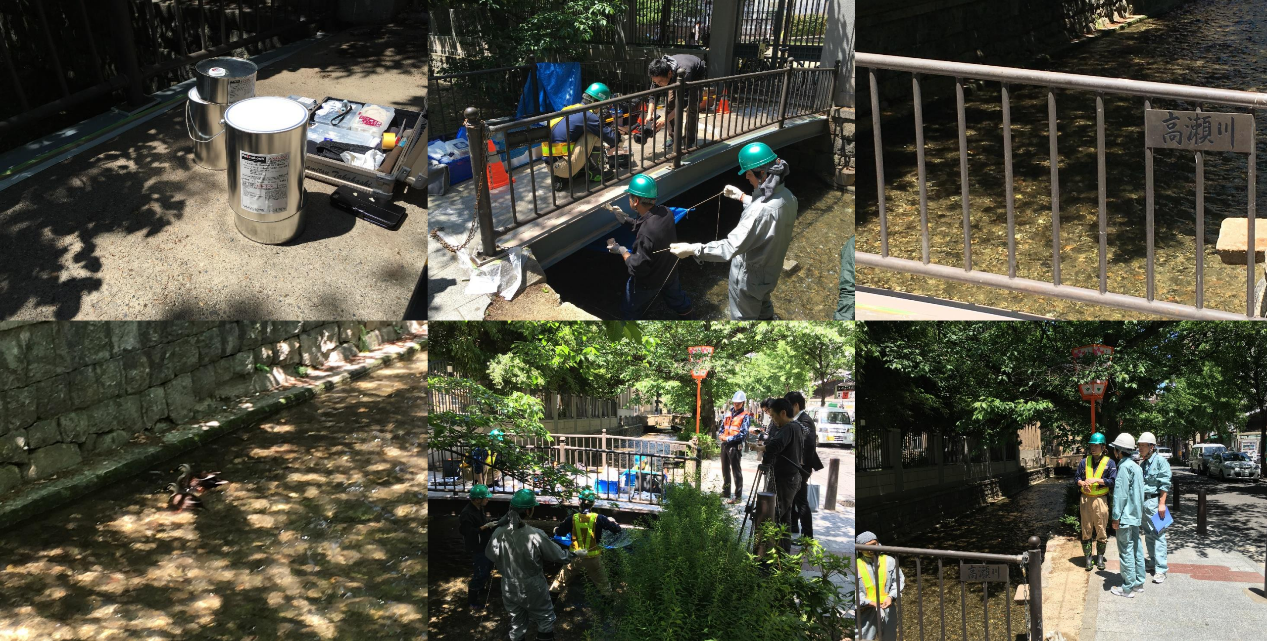
京都市高瀬川の備前島橋に Pat!naLock を施工(その他のスナップ)
